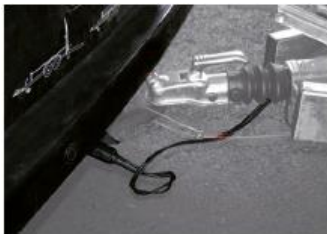
Bild: Stromversorgung anschließen
